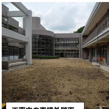
工事中の東棟外壁面
